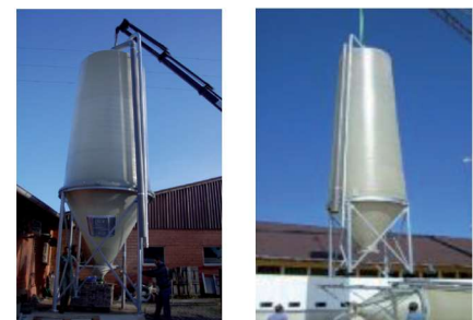
Montaje sencillo y muy rápido de silos estándar a través de un extenso preensamblaje.
