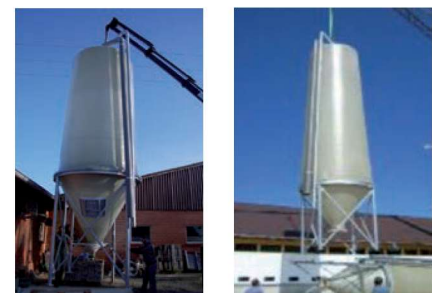
Assemblaggio semplice e molto veloce di silos standard attraverso un ampio pre-assemblaggio
