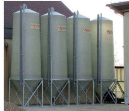
4 x 25 cbm Silos per semi
